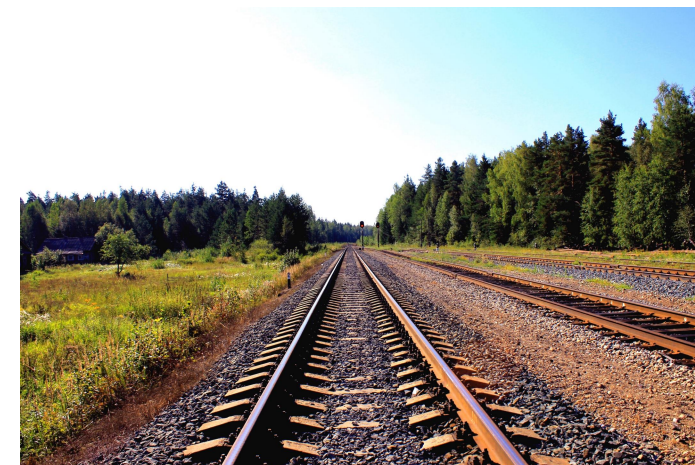
Строительство железнодорожной ветки для снабжения заводов
