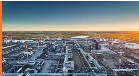
Обустройство месторождения Восточно-Мессояхское
