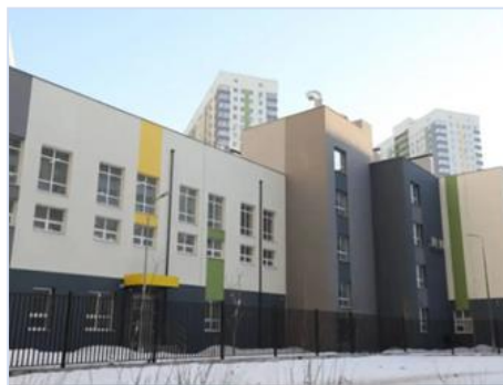
Капитальный ремонт школ
