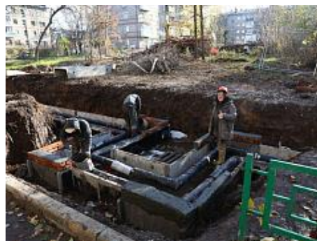
Реконструкция городских теплотрасс
